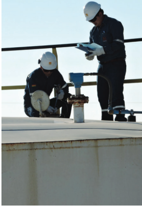
Prueba hidráulica a tanque estacionario
