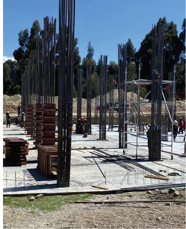
Construcción del primer piso del bloque principal
