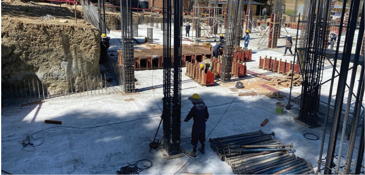
Armado de pilares de las oficinas de IBMETRO en Achocalla
