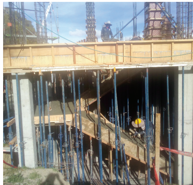
Construcción del segundo piso del bloque principal
