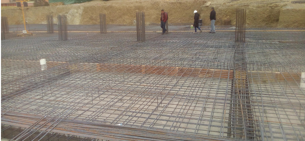
Construcción de la losa radier de fundación
