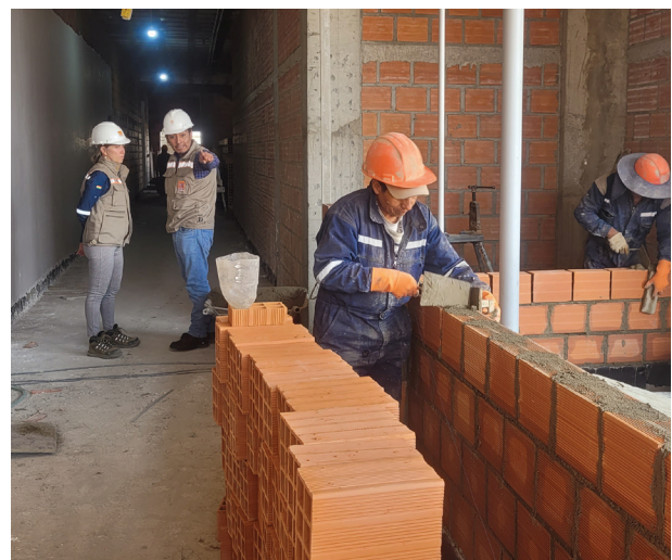
Proceso de construcción de los nuevos laboratorios
