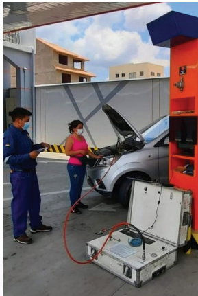
IBMETRO inspecciona los dispensadores de Gas Natural Vehicular
